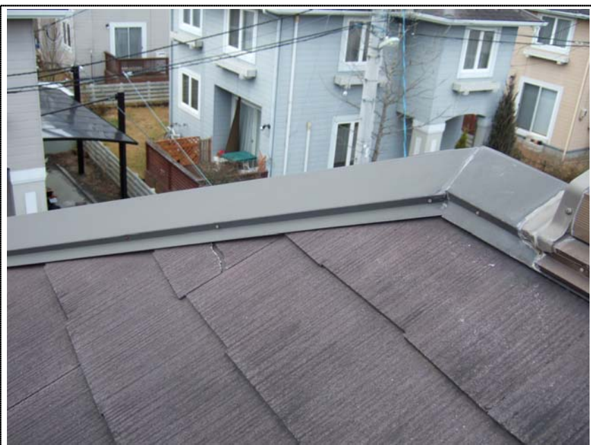
屋根西スレート破損.JPG
